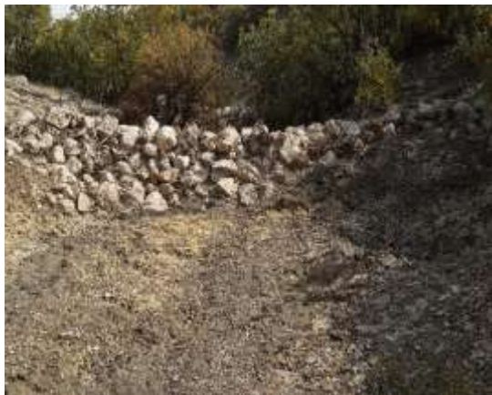
شکل ۳- نمایی از رسوب پشت بند و موقعیت بند در آبراهه
