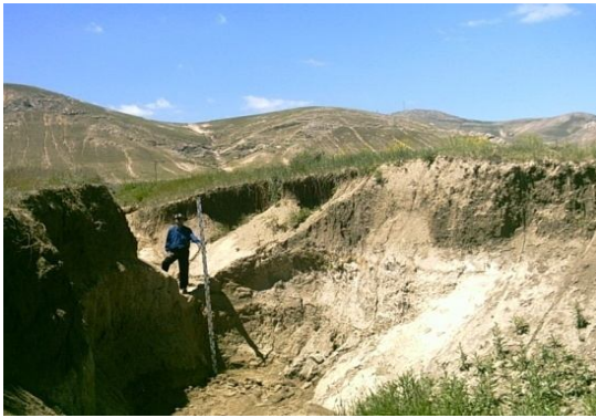
شکل ۵) عمیق تر شدن دوباره خندق در منطقه ریحانلو-استان آذربایجان غربی
